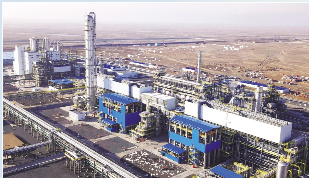
▲公司哈萨克斯坦IPCI项目PDH/VO装置，施工地点位于哈萨克斯坦阿特劳市卡拉巴升经济特区。公司承建了IPCI项目PDH装置工程三标段及VO装置标段的施工任务，工程量占到了整个项目50%。项目于当地时间2022年11月8日竣工。
