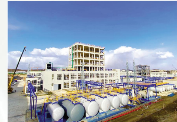
▲福建分公司威海新元高端新材料生产项目和无醛环保水性粘合剂项目，施工地点位于山东省威海市文登经济开发区，合同额为2.8亿元。目前，项目一期7个主要建设主体处于配合业主试车调试阶段，项目二期土建工程6个主要建筑主体主体结构施工完成。
