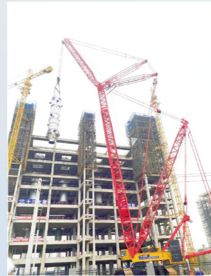
▲机械化分公司华鲁恒升(荆州)项目大型设备吊装工程，施工地点位于湖北江陵县。该项目吊装总量为9574吨，目前，吊装任务已完成36台、7493吨。
