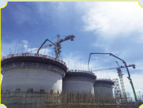
▲广东分公司富凌饲料蛋白、高科技食品及植物清洁能源一体化产业园项目，施工地点位于广东省广州市南沙区，合同额为1.6亿元。目前，项目4-1#室外消防水罐、27#油罐区及脱吸塔均已顺利完成交接，筒仓区域滑模工程正在有序推进，已完成进度87%，项目土建主体工程已完成90%，钢结构安装工程正在有序推进。
