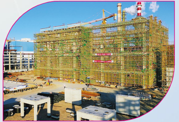
▲江苏分公司江苏新浦氨乙烯工程项目，施工地点位于江苏省泰兴市泰兴经济开发区，合同额为9000万元，目前项目20个单位工程的管道、钢结构、设备、电气仪表安装工作均在消除尾项阶段。
