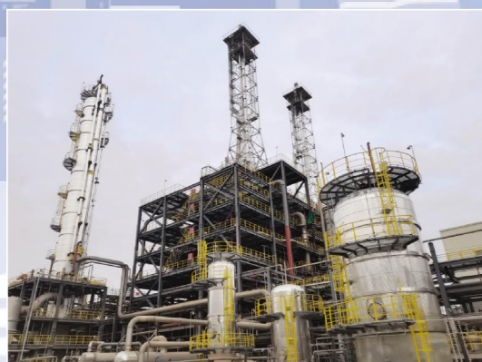
▲广东分公司内蒙古华恒能源科技有限公司PTMEG/PBAT新材料产业链一体化项目，施工地点位于内蒙古乌海市海南区巴音镇低碳产业园区，合同额为1.24亿元。目前，项目钢结构安装已完成，设备安装完成95%，工艺管道施工完成93%，电气仪表安装完成70%。
