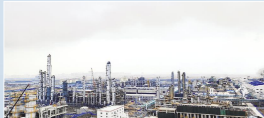
▲山东分公司沧州旭阳化工有限公司己内酰胺扩建项目，施工地点位于沧州市渤海新区，合同额为2亿元。项目于2022年8月9日顺利中交，并于9月25日一次性投产成功，顺利产出己内酰胺优等品，实现全流程贯通。
