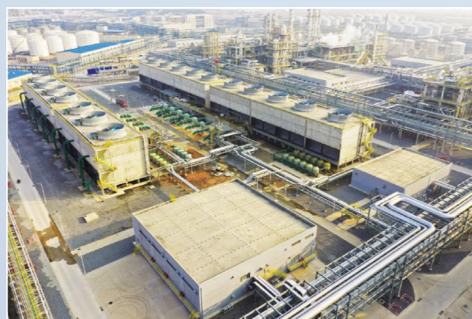
▲天津分公司广西华谊新材料有限公司75万吨/年丙烯及下游深加工项目公辅设施系统工程，施工地点位于广西壮族自治区钦州市钦州港经济技术开发区内，合同额为1.97亿元。2022年10月10日，项目完成最后一个主项的中交，目前已经进入收尾阶段。
