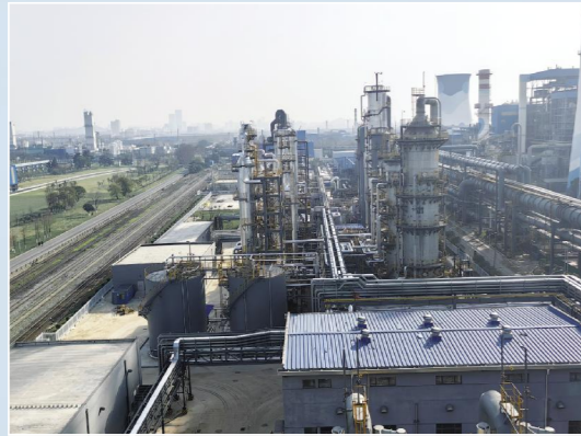
▲第一分公司安徽马鞍山钢铁股份有限公司炼焦总厂焦炉大修改造项目煤气净化部分，施工地点位于安徽省马鞍山市花山区马钢北区厂区内，合同额为1.94亿元。目前，项目所有工程均已完成，已进入试生产阶段。
