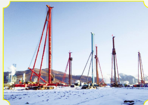
▲化勘设计院承建的吉林石化公司炼油化工转型升级项目—120万吨/年乙烯装置及开工锅炉桩基工程，施工地点位于吉林省吉林市龙潭区。目前，项目桩基施工钻孔已完成30%。
