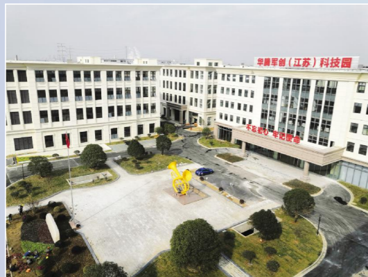
▲天津分公司华腾军创(江苏)产业园项目，施工地点位于江苏省无锡市梁溪区，合同额为1.32亿元。目前，项目已进入竣工验收阶段。
