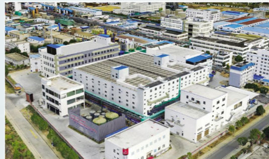
▲山西分公司湖北宏源六氟磷酸锂升级改造项目，施工地点位于湖北省黄冈市罗田县经济开发区内，合同额为2.1847亿元。目前，该项目已全部施工完成，并已交付业主使用，全线进入投产运营阶段。
