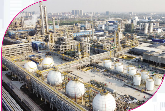
▲山西分公司丝路科创谷工程项目，施工地点位于陕西省咸新区沣西新城，合同额为7亿元。目前，项目正处于主体施工阶段，其中3#、7#、13#主体施工已完成70%，其他6栋楼正处于基础验收阶段。
