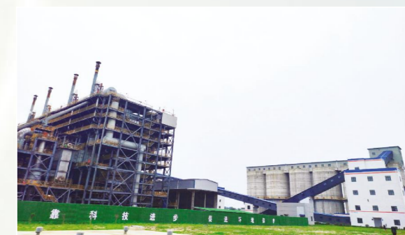
▲第七分公司安阳瑞曼达清洁能源有限公司陶瓷园区清洁工业燃气集中制气项目，施工地点位于河南省安阳市内黄县陶瓷园区区三路，合同额为1.08亿元。目前，项目处于待交工验收阶段。
