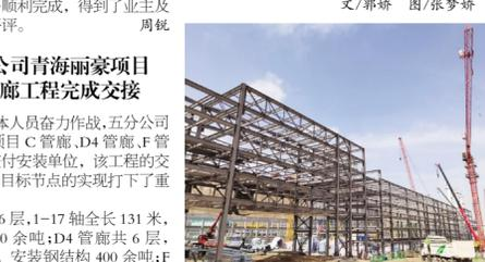
图为青海丽蒙高纯晶硅项目C管廊、D4管廊、F管廊钢结构主体顺利移交安装单位
