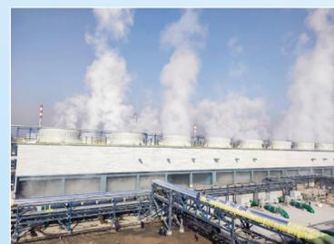
▲冷却技术公司江苏苏尔邦二期丙烷产业链新建5000m<sup>3</sup>/H×20台冷却塔项目,施工地点位于江苏省连云港市连云石化基地内。目前,项目已完成所有施工安装工作,10台冷却塔已经投入使用,剩余10台冷却塔正在配合业主单位进行试车工作。
