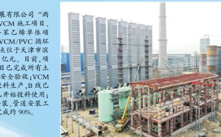
▲山西分公司阿拉善盟沪蒙能源实业有限公司300万吨/年焦化项目,施工地点位于内蒙古阿拉善高新技术产业开发区巴音包工业园区,合同额为4.3亿元。目前,项目主体工程完成95%,钢结构安装完成60%,设备安装完成70%,工艺管道预制完成40%,电气仪表安装完成40%。
