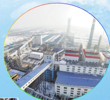
▲新疆中能万源化工有限公司400千吨/年合成氨、600千吨/年尿素项目(二期工程),施工地点位于新疆昌吉回族自治州玛纳斯县塔西河工业园区,合同额为1.5亿元。目前,气化装置钢结构安装完成60%,设备安装完成80%,管道预制完成27%。
