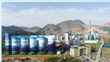
▲第二分公司湖北云华化工有限公司30万吨/年合成氨搬迁技改项目,施工地点位于湖北省武穴市,合同额为6915万元。项目于9月24日投料开车一次成功。12月24日16时39分,项目顺利通过72小时性能考核,实现平均负荷106.62%稳定无间断运行,各装置消耗、产量、环保等指标均满足或优于合同规定的性能保证值。
