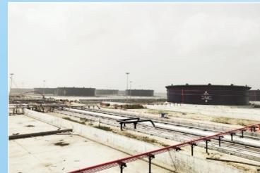
▲尼日利亚莱基自贸区公司丹格特2000万吨炼油桩基土建设备项目,施工地点位于尼日利亚拉各斯莱基自贸区,合同额为1.36亿美元。目前,桩基施工已完工,土建设备项目施工完成91%,储罐制作安装施工完成96%,收尾及结算工作正有序推进。
