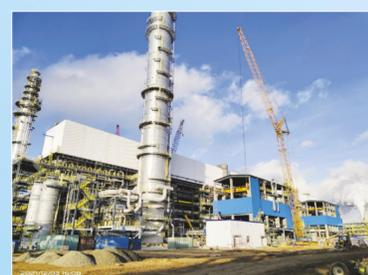
▲公司哈萨克斯坦石油工业公司石油一体化(IPCI)项目PDH装置(标段III),施工地点位于哈萨克斯坦阿特劳市卡拉巴什经济特区,合同额为7200万美元。目前,项目工艺管道、电气、成套设备等已基本安装完成,管道试压工作已全面启动,项目已逐步由施工阶段转入预试车阶段。
